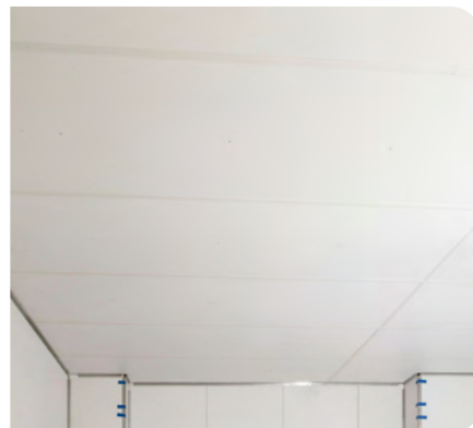
RenoPanel als hygiënisch plafond in een vleesverwerkingsfabriek.
