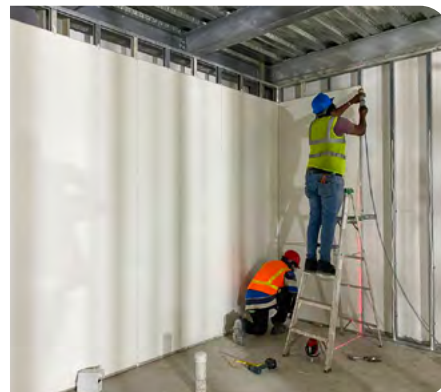
RamPanel kan worden geïnstalleerd op metal studs.
