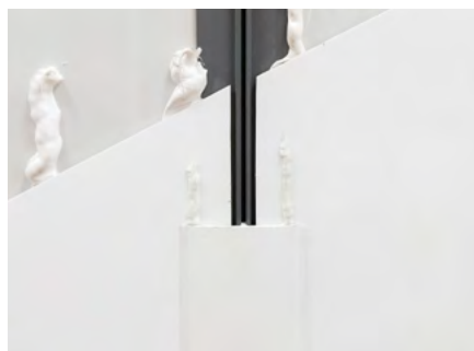
CleanSheet afgewerkt met PVC profielen.
