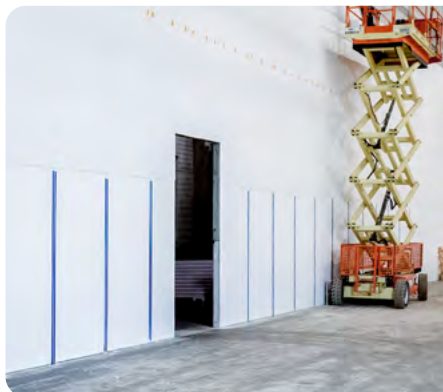
RamPanel voorbereid met blauwe tape voor HygiSeal 3.1 installatie.
