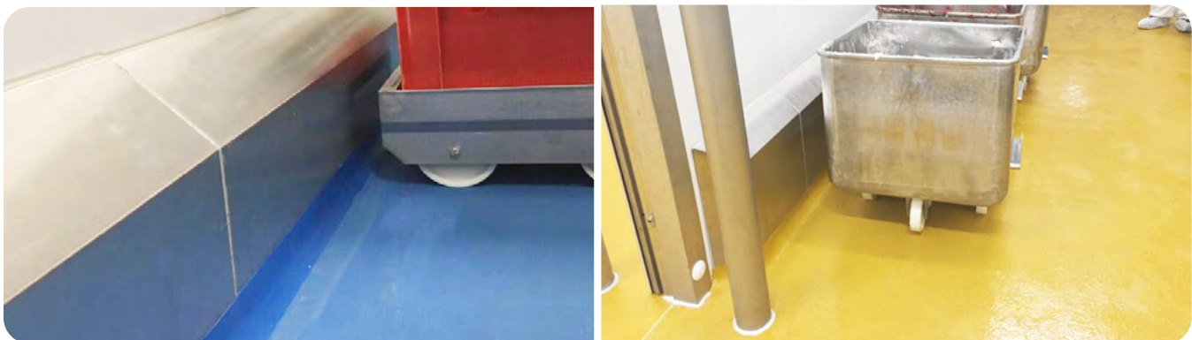
PolySto Prefab ICS40RB RVS stootrand met betonnen kern.
