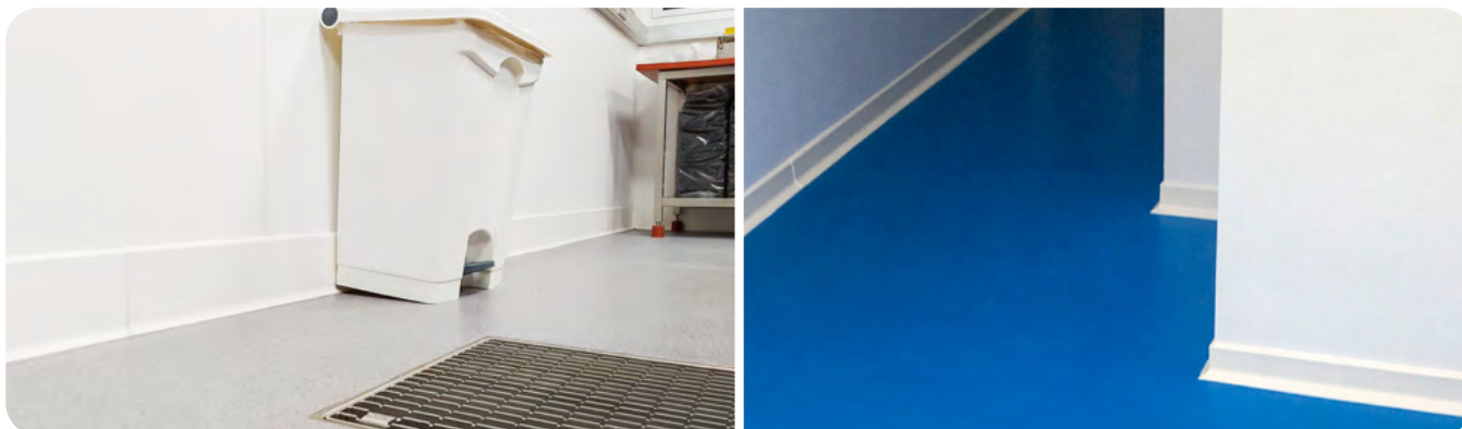
PolySto Prefab PV15F PVC plint gemonteerd tegen een CleanSheet reliëfplaat, afgewerkt met HygiSeal.
