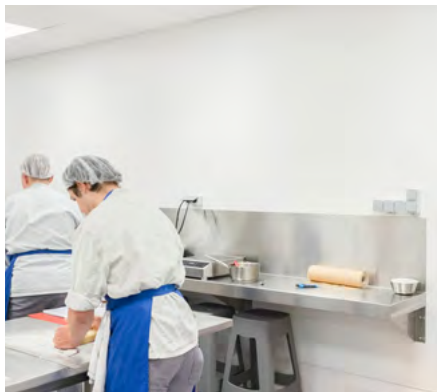
RamPanel in een bakkerij.
